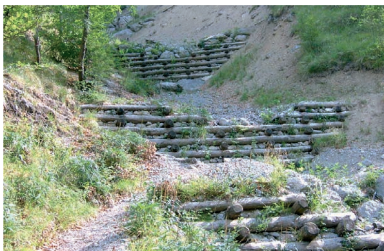
Serie di briglie realizzate con la tecnica dell'ingegneria naturalistica sul Fosso delle Logge, Sottobacino Turrice di Galliciano in Comune di Stazzema (LU) (Foto estratta dal Censimento delle opere idrauliche del Comprensorio di Bonifica n. 4 "Valle del Serchio")
